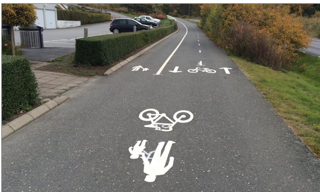
MYND 3 Sameiginlegur göngu- og hjólastígur fer yfir í að verða aðgreindur hjólastígur og gönguleið (Gautaborg, Svíþjóð).
